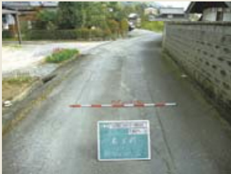
施工前(町道寺前サルバミ線)
