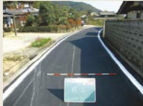
施工後(町道寺前サルバミ線)
