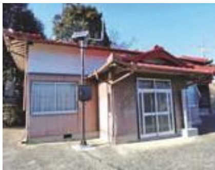
大藤に設置した防災灯
