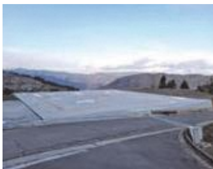
コンクリート舗装した 加茂山ヘリポート
