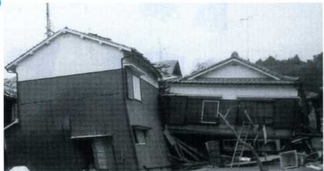
阪神・淡路大震災で倒壊した木造住宅
