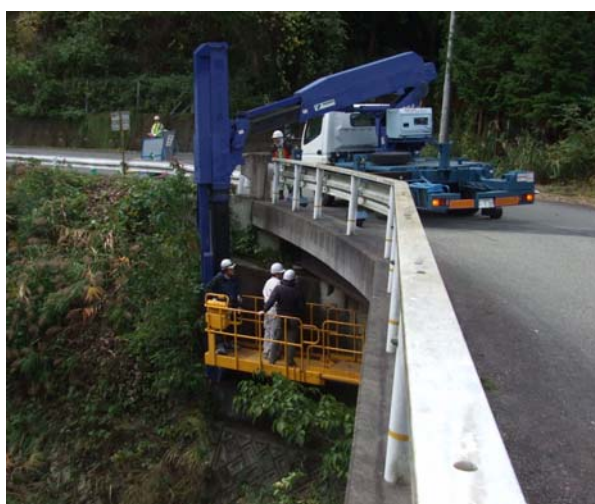
写真1 定期点検状況（平成22年、橋梁点検車による点検状況）
