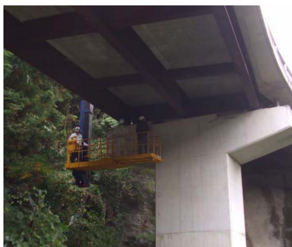
写真1 定期点検状況（平成22年、橋梁点検車による点検状況）
