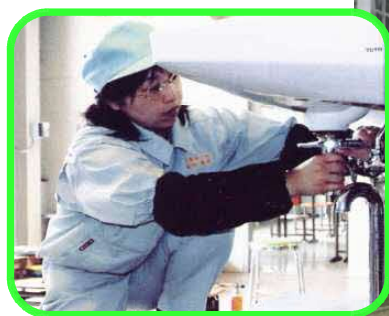
衛生設備の取付け
