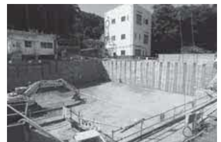
大規模に床掘中の浄化センター
