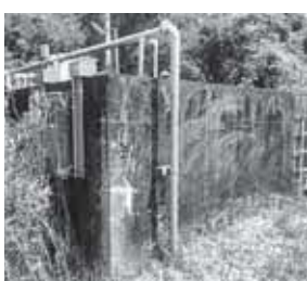
新居田配水池
