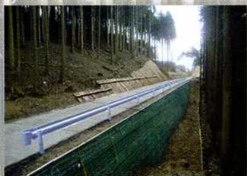
現場発生土を利用した補強土壁
