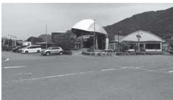
オアシスの街路灯を整備
