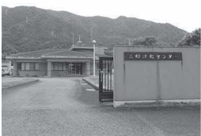
三好浄化センター
