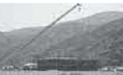
建設中の新火葬場
