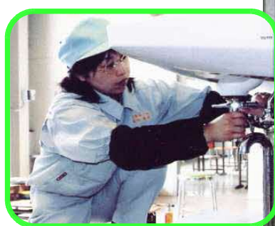
衛生設備の取付け
