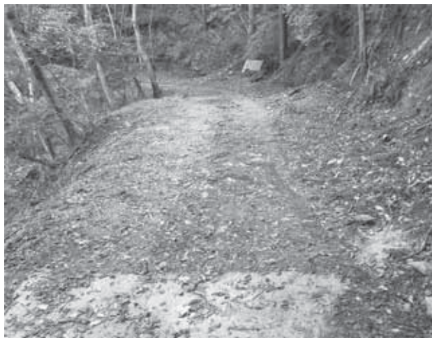
舗装整備される林道三蔵窪線、現在の様子
