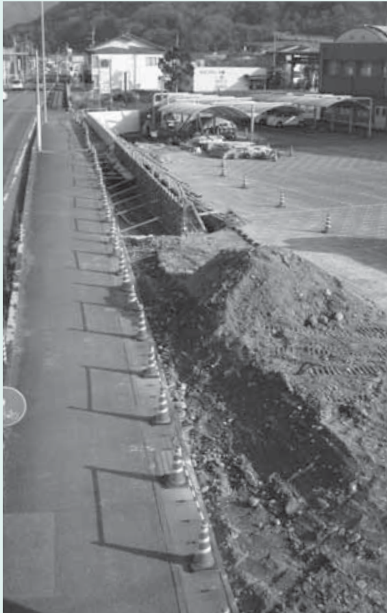
工事中の庁舎駐車場部分
