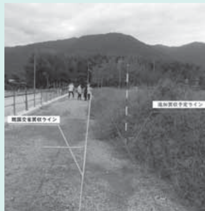
町道加藤久保田支線工事予定地
