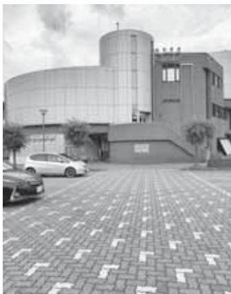
北側駐車場から見た三加茂庁舎
