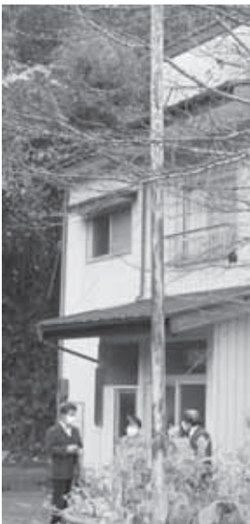
修繕される山口生活改善センター
