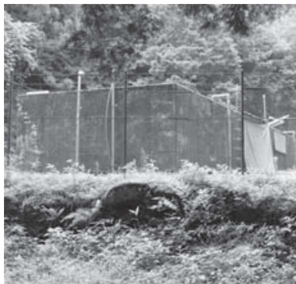
簡易水道のタンク
