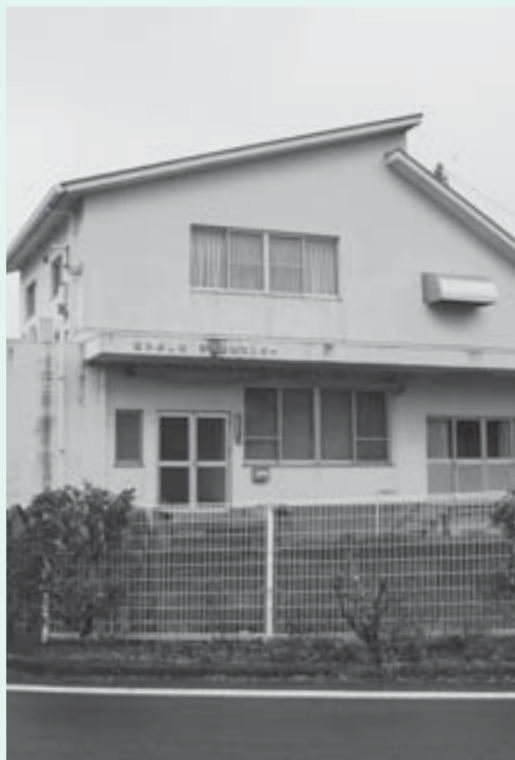
防災用品備蓄庫として使われている旧給食センター
