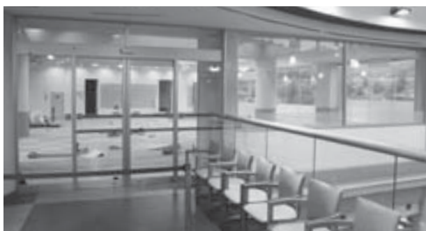
改修が進む2階西側
