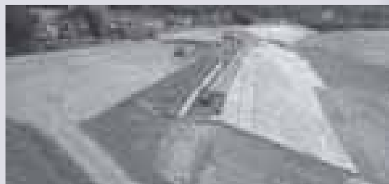
着々と進む加茂第2堤防工事
