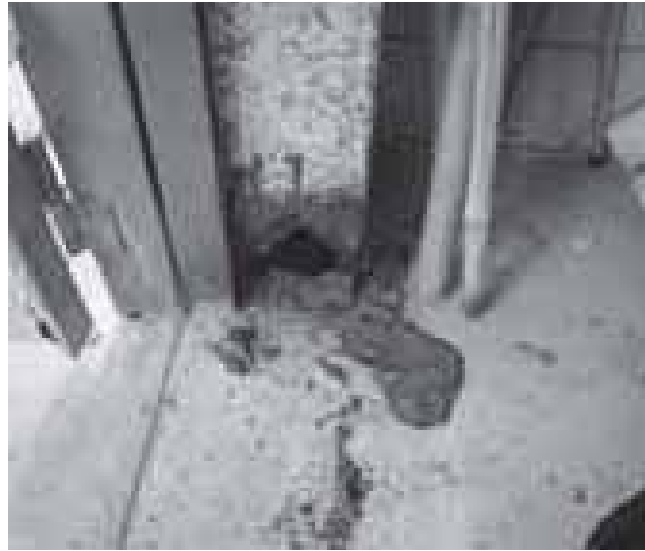
修繕するボイラー室入り口
