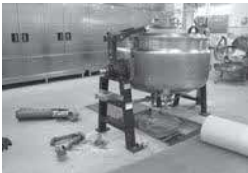
配管の修繕が必要な回転釜
