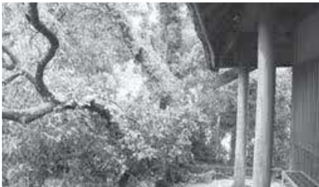
木々が倒れ掛かった建屋
