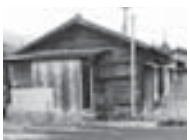
解体された町営住宅
