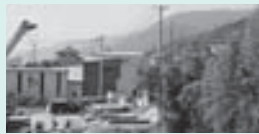
電柱が移設された工事現場
