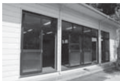
網戸が設置される昼間幼稚園遊戯室
