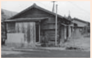
解体される町営住宅
