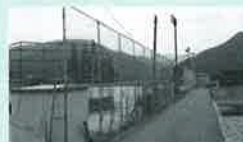
改修する防球フェンス
