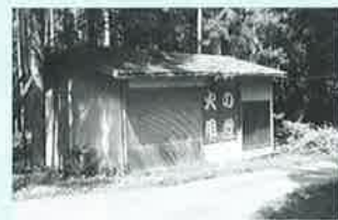
老朽化した詰所
