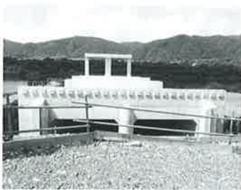
建設中の稲持谷川樋門
