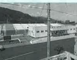
全面改修するB&G海洋センター
