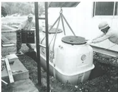
浄化槽設置工事
