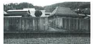
岸下畑地灌漑用水のタンク
