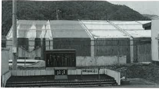
屋根の一部を修理したプール
