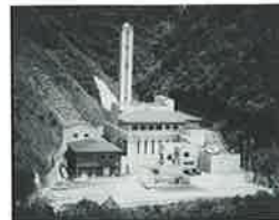
老朽化した焼却場
