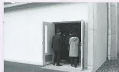
加茂小学校体育館の防災倉庫
