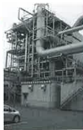
バイオマス発電所
