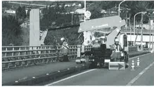
点検中の三三大橋
