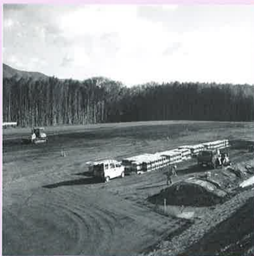
工事中のぶぶるパーク
