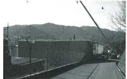
工事中の足代第1浄水場簡易水道タンク
