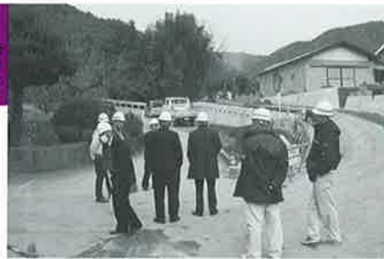
町道行安山口上線改良工事
