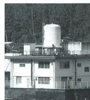
昼間簡易水道第2浄水場
