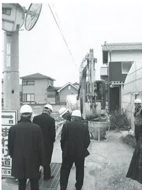
町道貞広金川線改良工事
