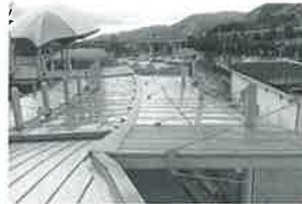
改修されるオアシスの屋根
