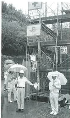
足代簡易水道の工事現場
