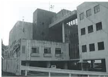
老朽化がすすむ公共施設
