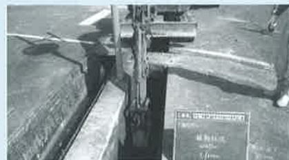
簡易水道工事
