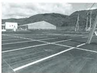
拡張した駐車場
