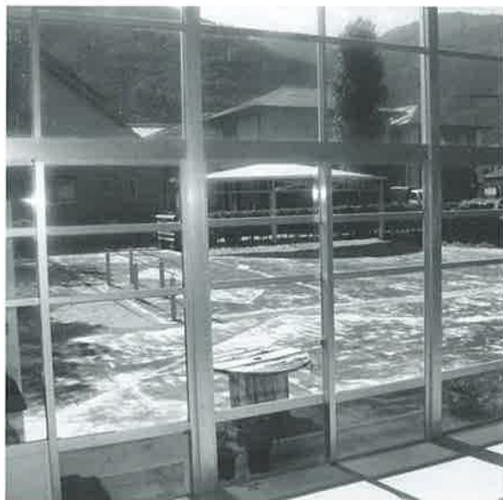
飛散防止フィルムを貼った窓ガラス
