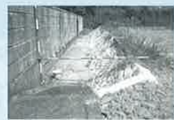
工事予定箇所
