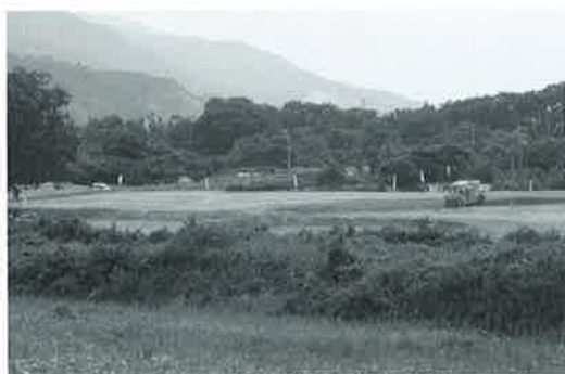
三三大橋から見た築堤建設風景
