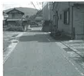
工事が予定されている鍛冶屋敷の県道
