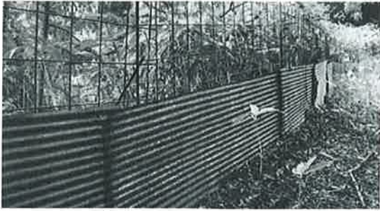
トタン板と一緒に設置されたワイヤーメッシュ柵(例)
