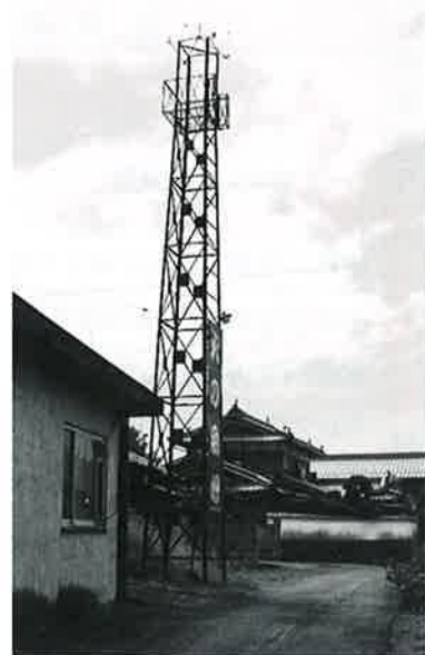
老朽化した半鐘台
