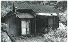
解体撤去する東山町営住宅
