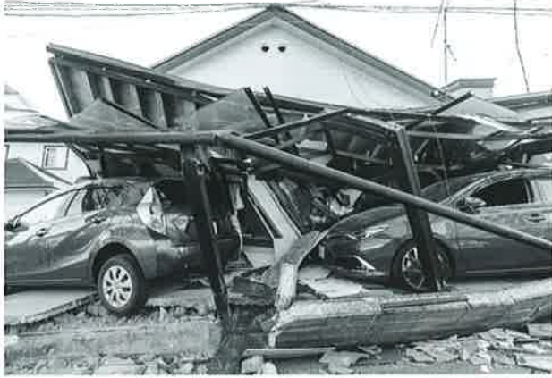
熊本地震での家屋の倒壊
