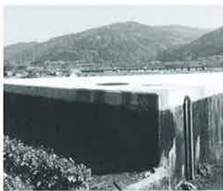
床版設置（施工例）
