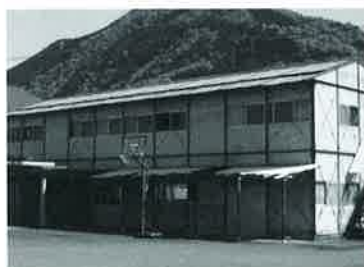
取り壊される柔道場
