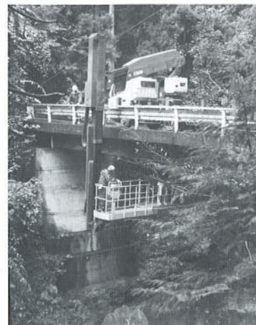
蔭橋の点検作業中
