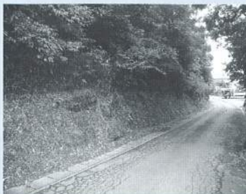
電源立地交付金で法面工事がされる
