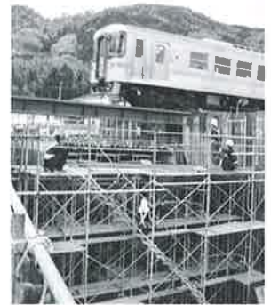
▲工事が進む町道谷門横峰線
