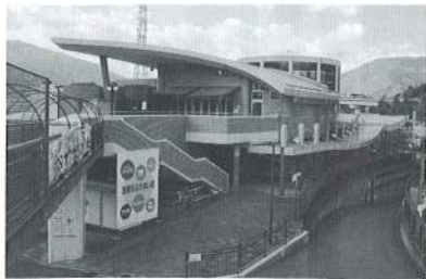
大幅な改修が必要なオアシス
