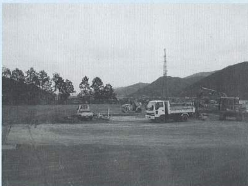
造成が進む保育所建設予定地
