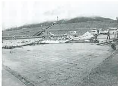
台風12号による被災状況
