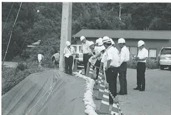
台風で被災した現場
