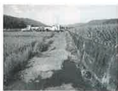
町道綿ノ久保古田線
