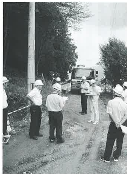
町道滝宮線の工事現場
