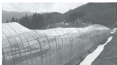
雪で倒壊したハウス
