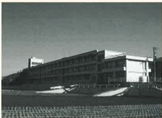
加茂小学校3階部分を改修
