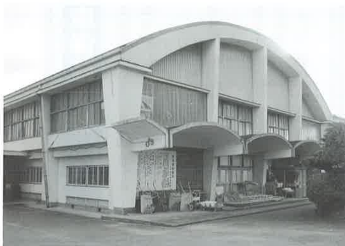
三好中学校体育館
