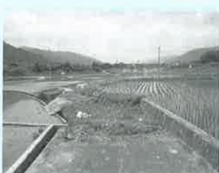
町道綿ノ久保古田線
