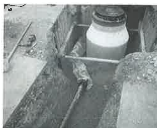
水道管布設工事
