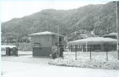
三好浄化センター
