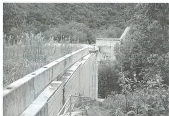
橋の建設が待たれる橋台
