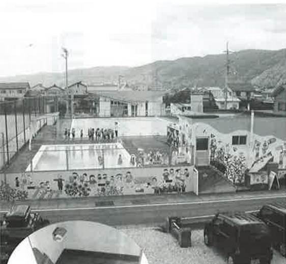
三庄小学校プール
