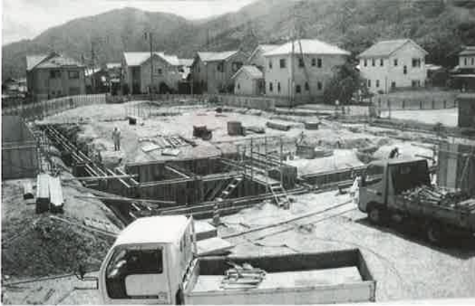
工事中の三庄小学校体育館
