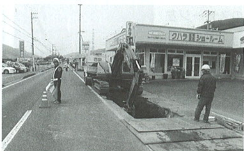
下水道工事(足代)
