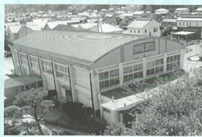
三庄小学校体育館
