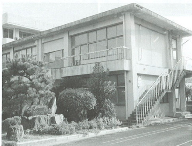
三庄小学校管理棟
