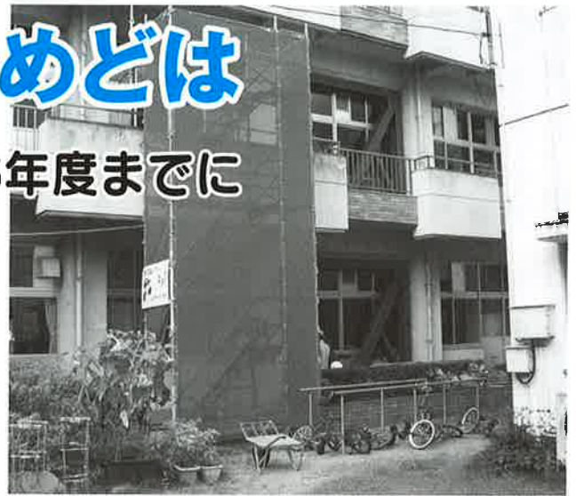
昼間小学校の耐震化工事
