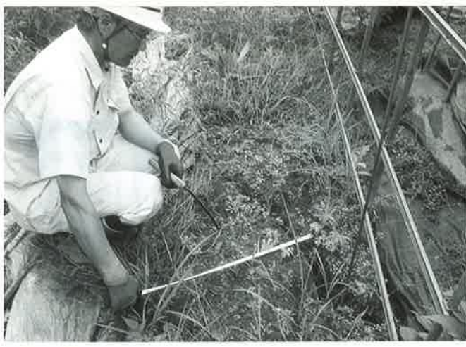
ひび割れた地面
