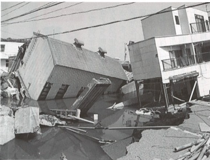
地震で倒壊した家屋
