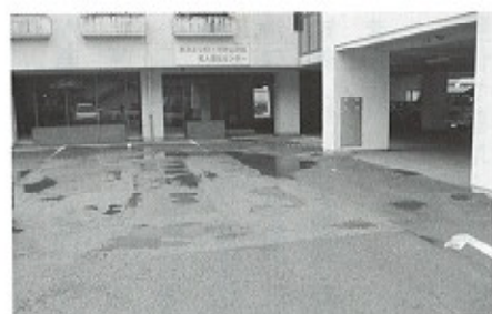
修繕される駐車場
