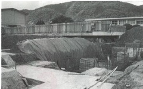
建設中の足代小学校体育館
