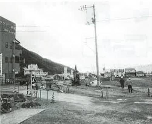
スポーツセンター線 国道への接続部分の工事
