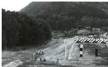
吉野川堤防の高水敷
