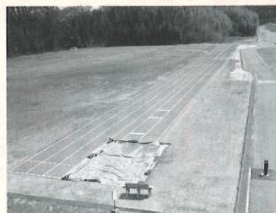
新設された陸上レーン
