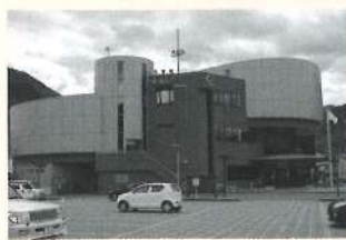
増築が予定されている三加茂庁舎
