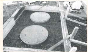
設置中の合併浄化槽
