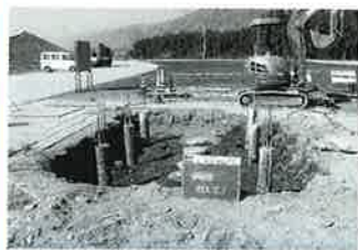
合併浄化槽埋設状況
