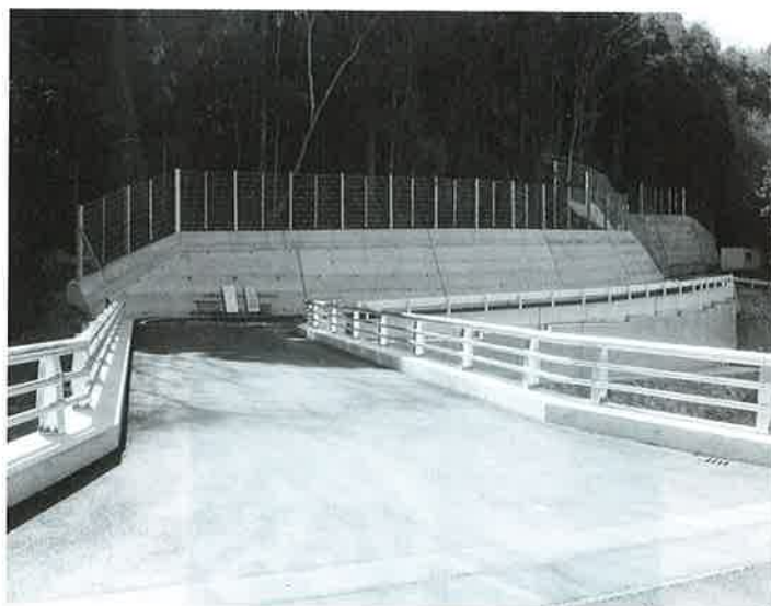
町道三枝線の改良工事
