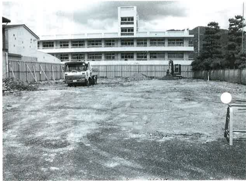
工事中の加茂小学校体育館
