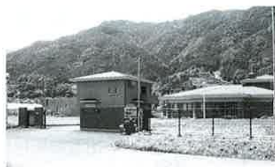
三好浄化センター
