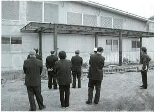
増築中の三加茂学校給食センターを視察する委員
