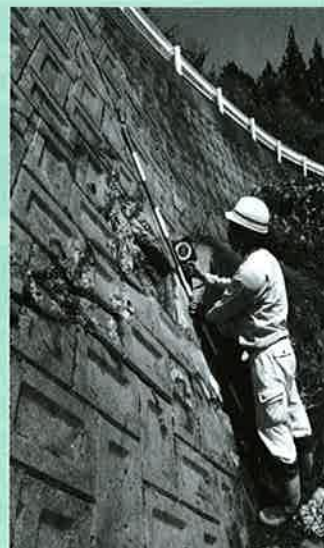
被災した大藤地区町道中込線
