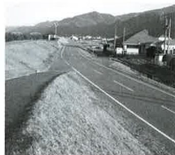
加茂第1堤防沿いの側道
