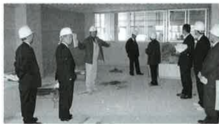
建設中の管理棟の視察
