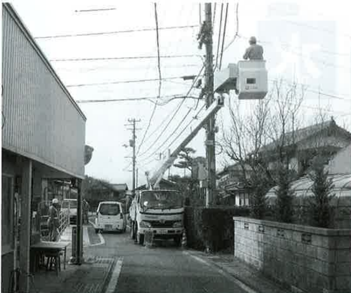
情報通信 屋外工事
