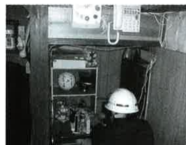
情報通信 室内工事中
