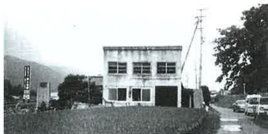
三好南岸土地改良区 滝下揚水機場
