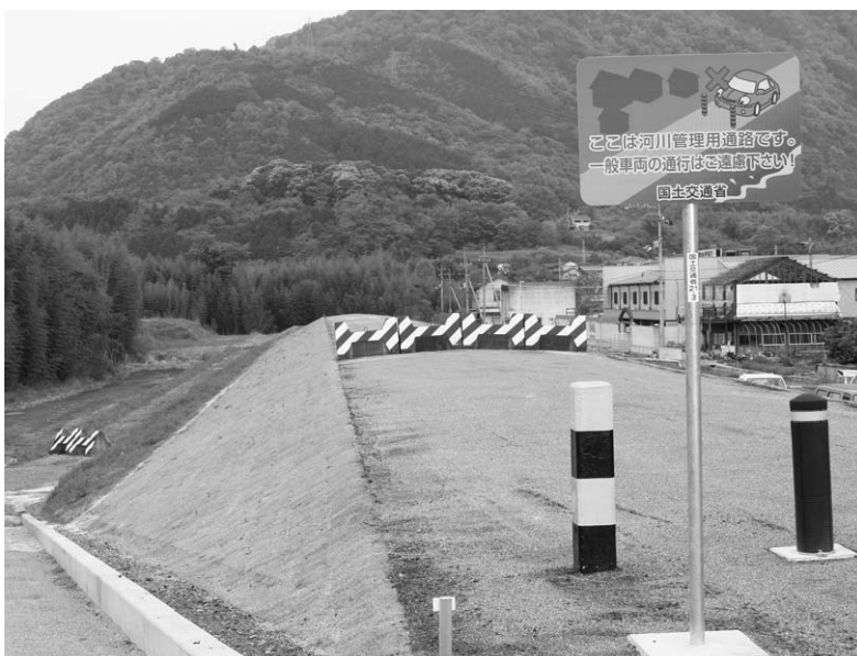
建設中の堤防工事
