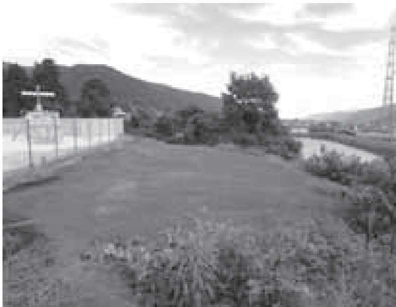
拡張される南側の法面
