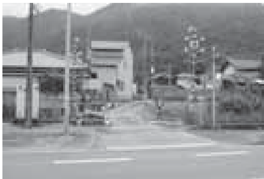
緊急車両が通れない稲持の踏切
