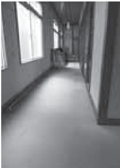
三好老人憩いの家の改修される廊下
