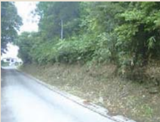
施工前(町道新町土井線)
