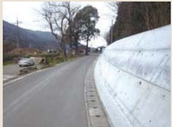
施工後(町道新町土井線)
