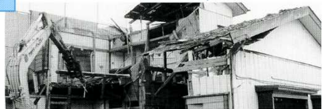
▲外装材・上部構造部分の取り壊し
