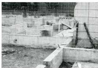
▲基礎及び基礎杭の取り壊し▲
