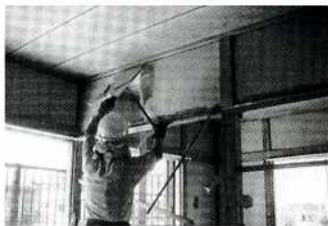
▲建築設備・内装材等を分別して取り外し▲
