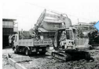
▲基礎及び基礎杭の取り壊し▲
