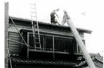
▲屋根ふき材を取り外し
