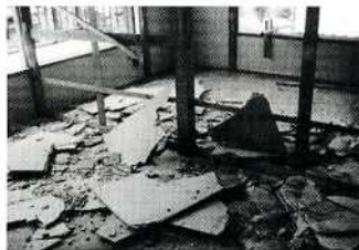
▲建築設備・内装材等を分別して取り外し▲
