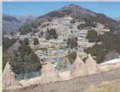
落合集落（三好市）：標高差400mに広がる集落に民家や一つひとつ積み上げられた石垣と畑などの光景は懐かしい山村の原風景を醸し出しています。
